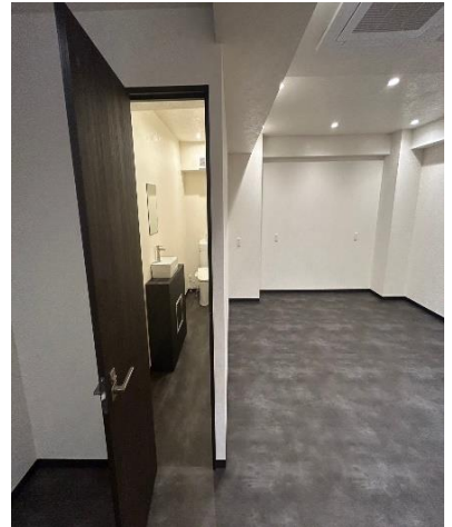
個室トイレ新設
