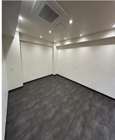
空調設備新設
