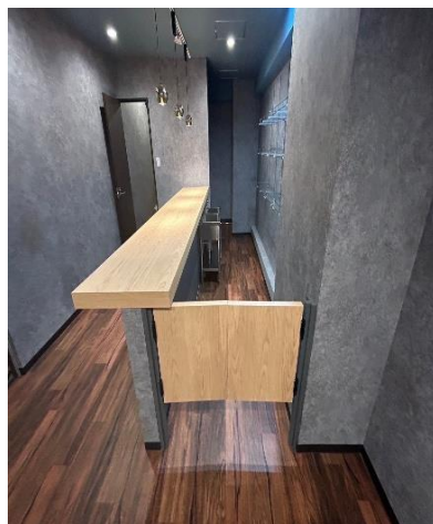
カウンター扉新設
