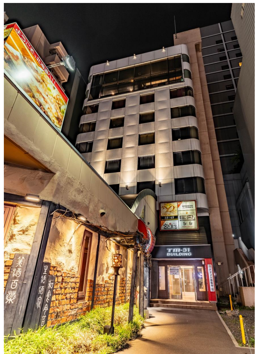
TM31ビル 12台設置
