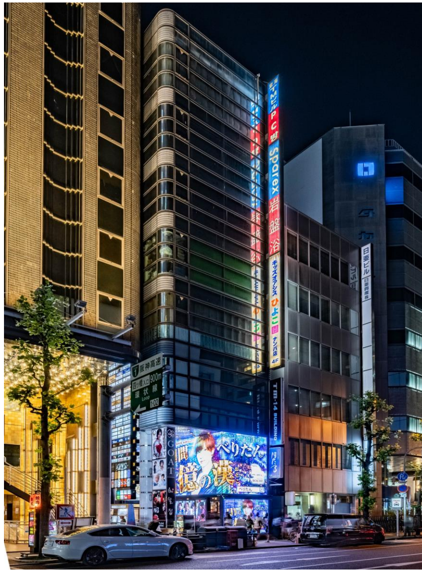
TM14ビル 17台設置
