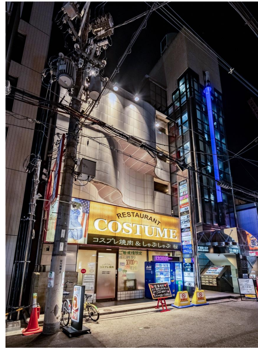
TM17ビル 18台設置
