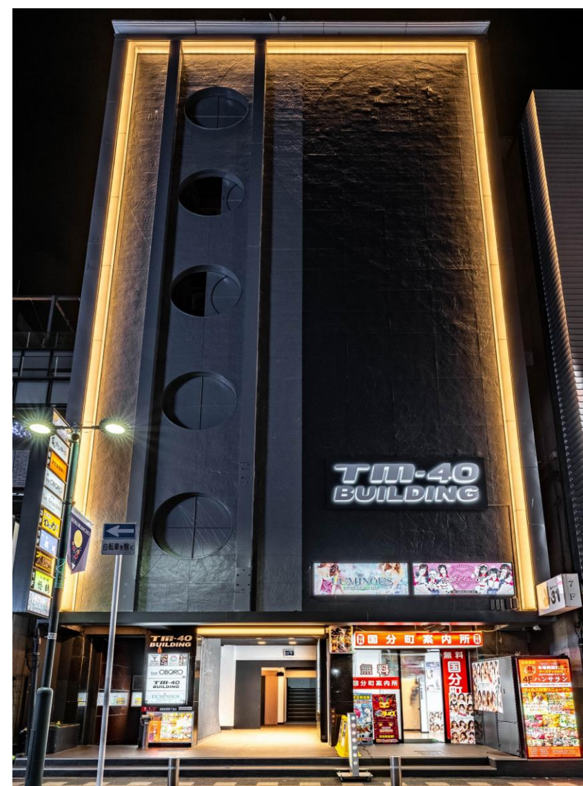
TM40ビル 42台設置
