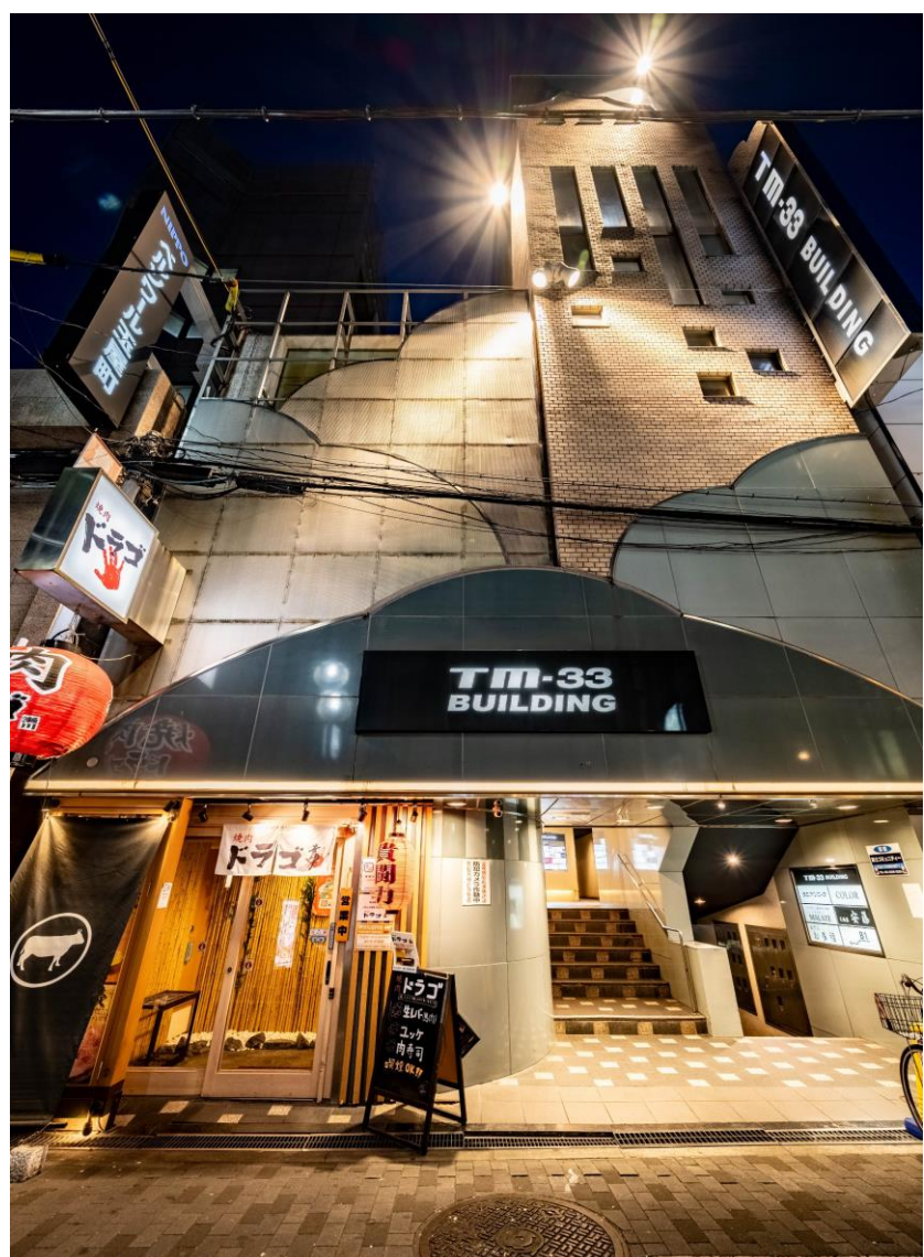
TM33ビル 22台設置
