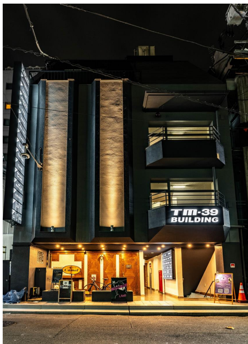
TM39ビル 14台設置
