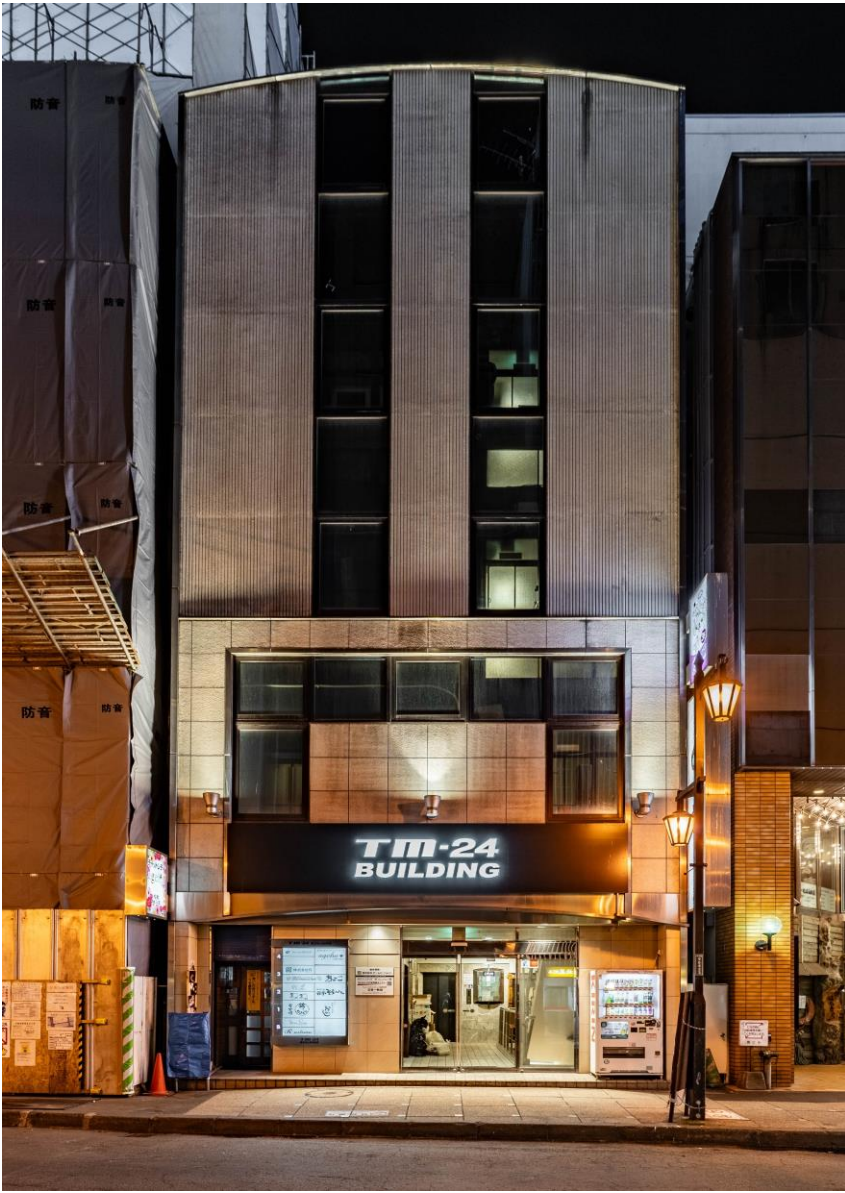
TM24ビル 7台設置
