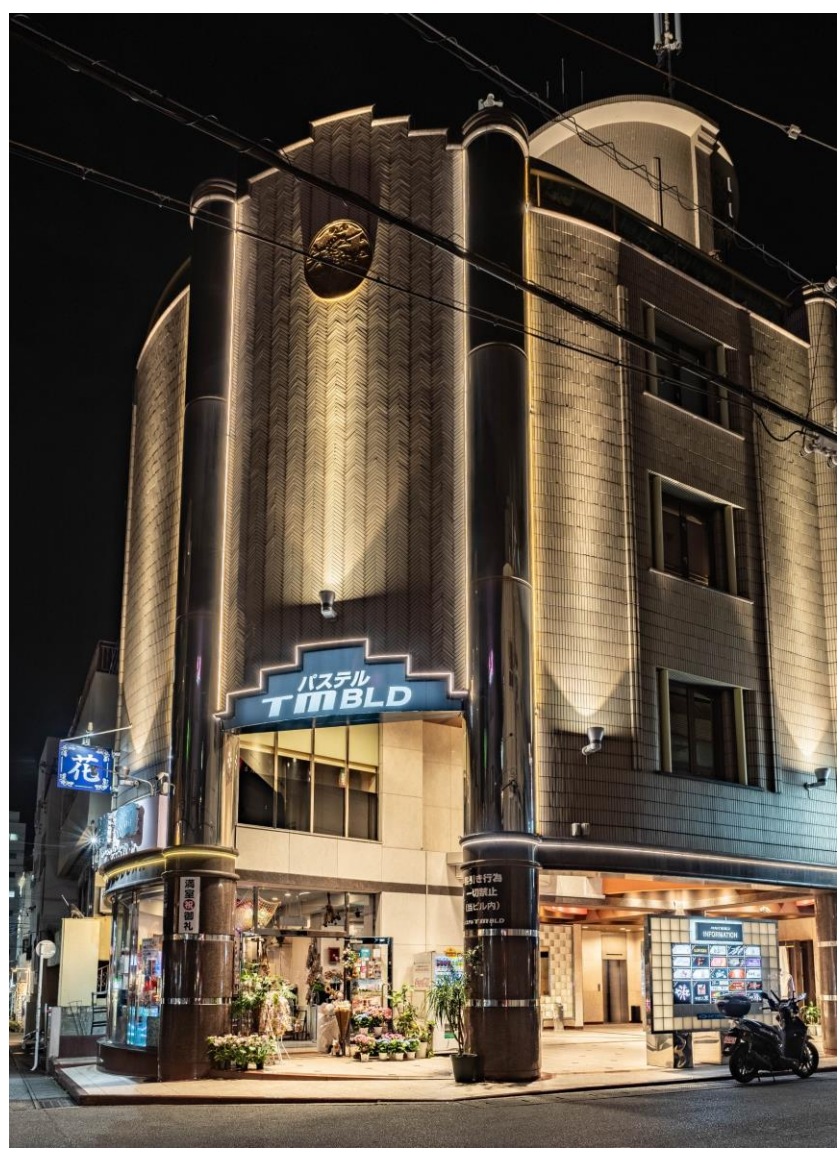
パステルTMビル 29台設置
