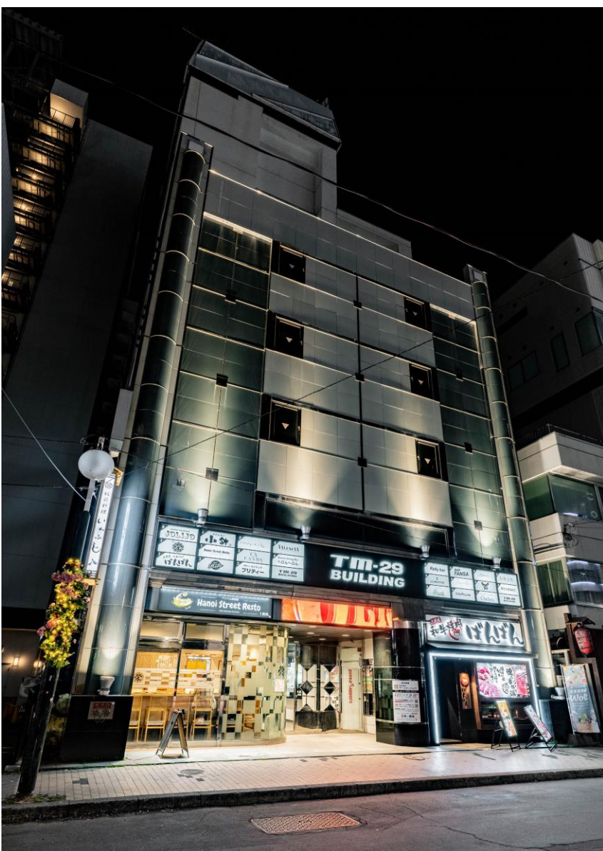
TM29ビル 22台設置
